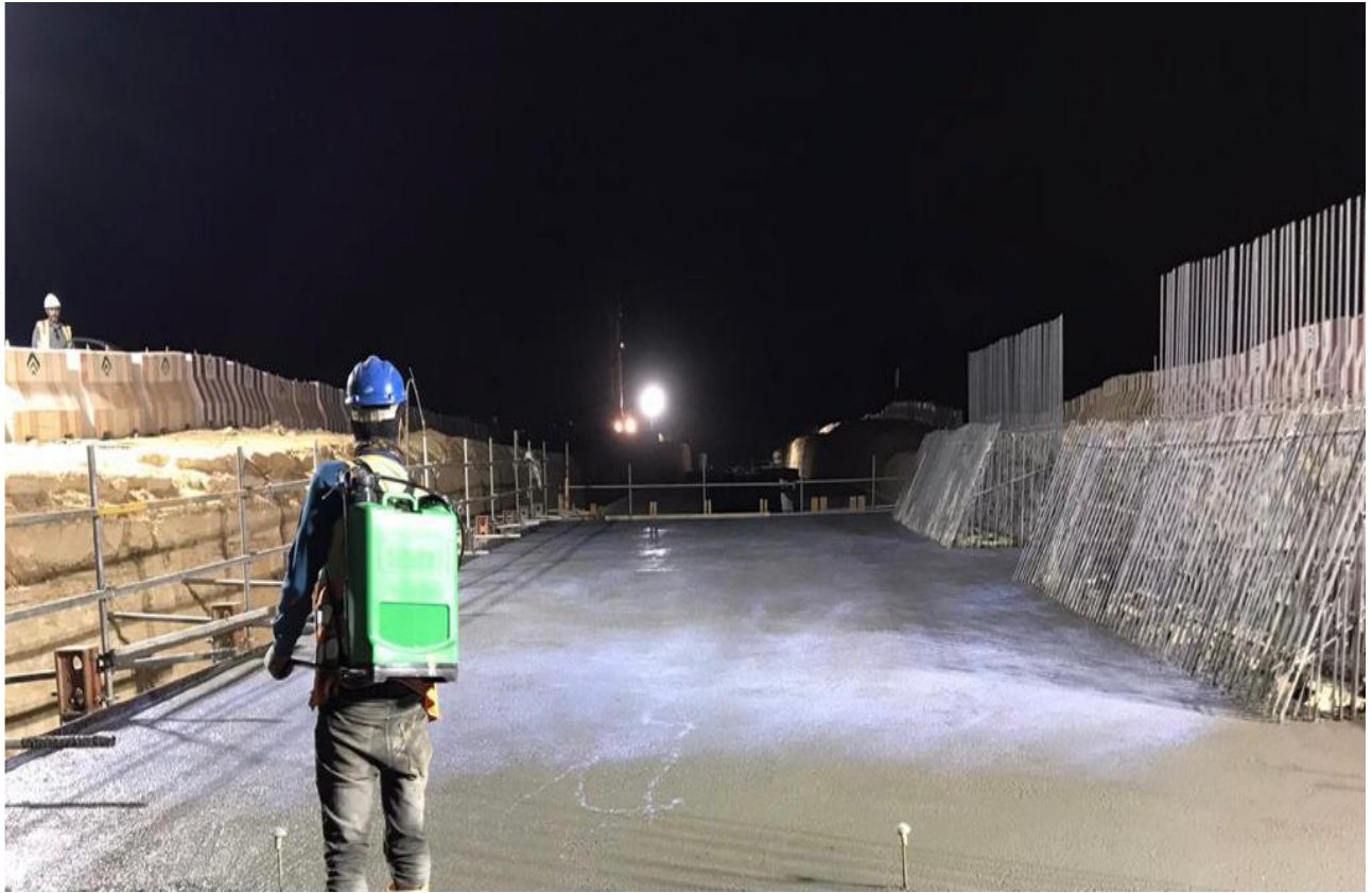
(شكل رقم 29) معالجة الخرسانة بالمواد الكيميائية (compound)
