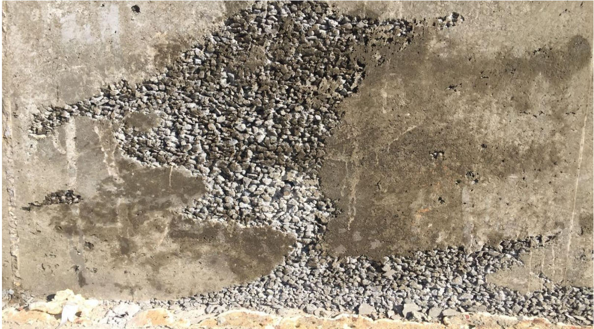
(شكل رقم 31) يبين التسوس فى الخرسانة (Segregation)
