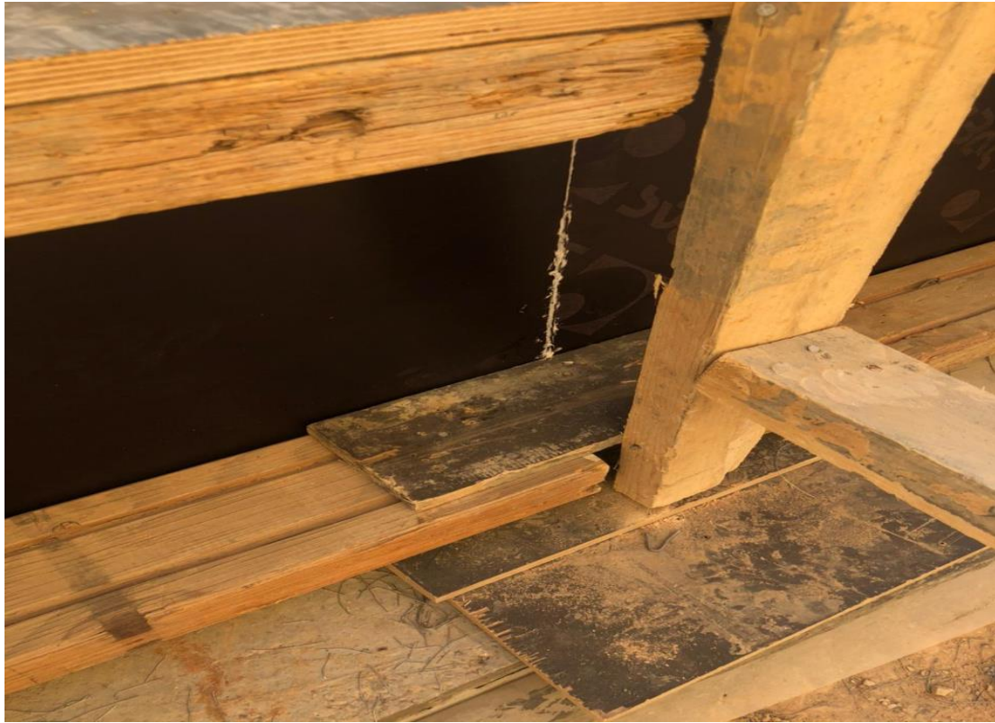
(شكل رقم 16) يوضح التدعيم الجيد للفورم وتفتيل الفتحات بالسلكون حتى لا تتسرب المونة الاسمنتية
