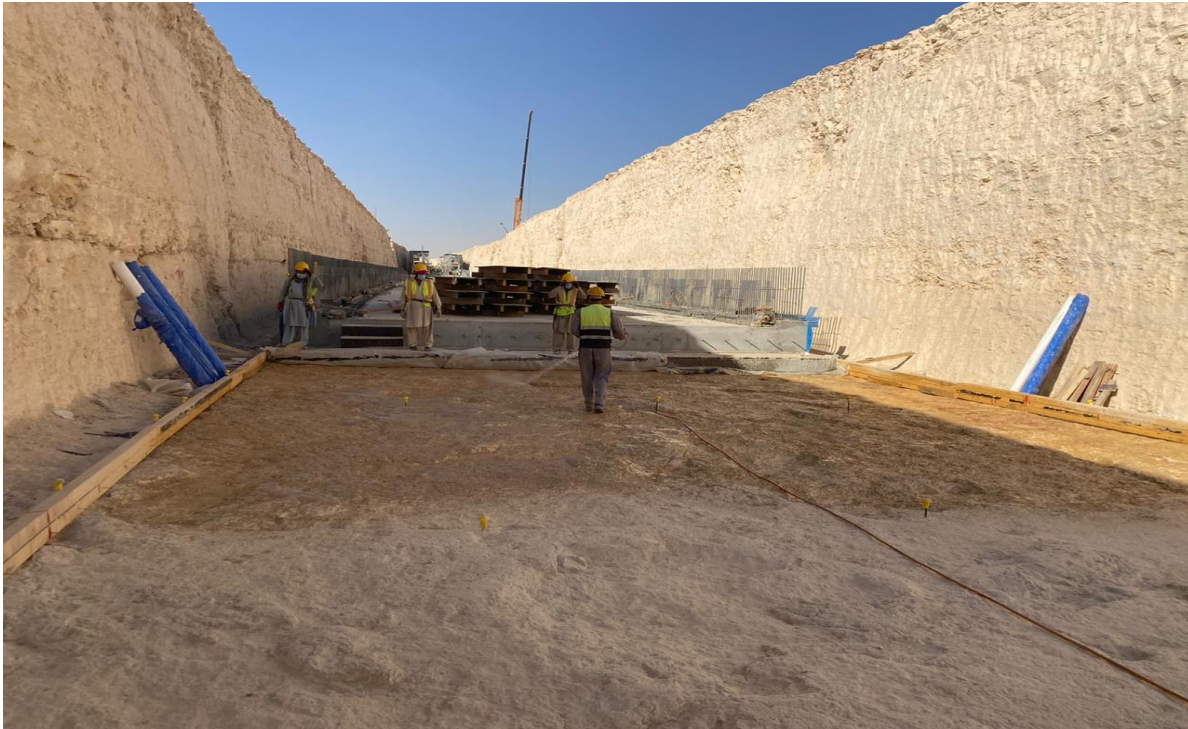
شكل رقم 9 يوضح رش مبيد النمل الابيض بعد النظافة وقبل وضع عازل الماء POLYSHEET
