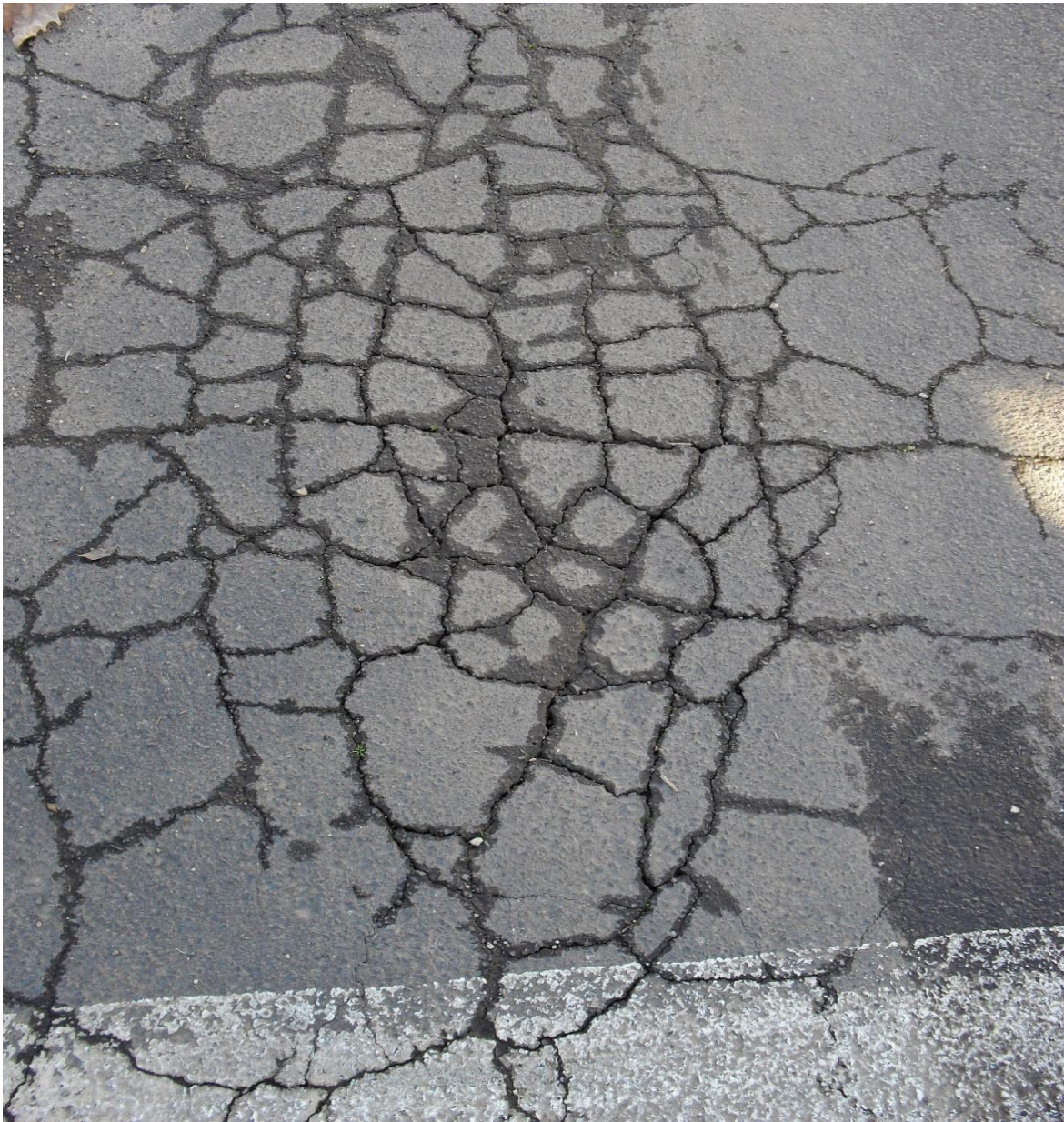
(شكل رقم 35) يبين التشققات السرطانية
