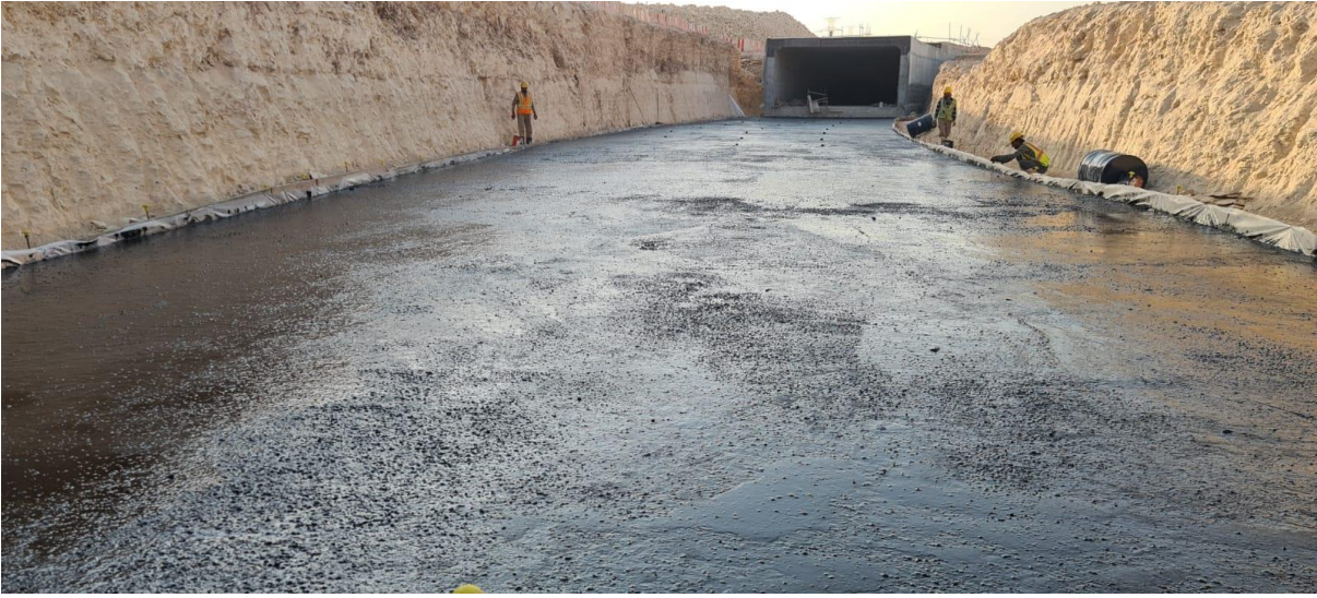
(شكل رقم 39) ويلاحظ اكتمال بعض الوحدات و إحدى الوحدات فى مرحلة الاعداد فرد طبقتى البيتومين اعلى الطبقة البلاستيكية
