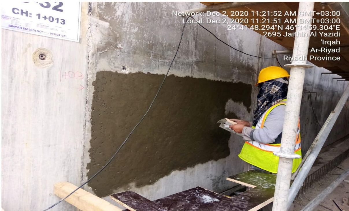
(شكل رقم 33) معالجة التسوس بمادة الجروت
