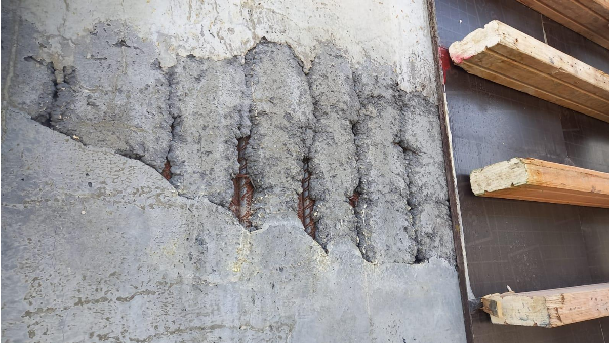
(شكل رقم 34) يلاحظ التعشيش و ظهور حديد التسليح
