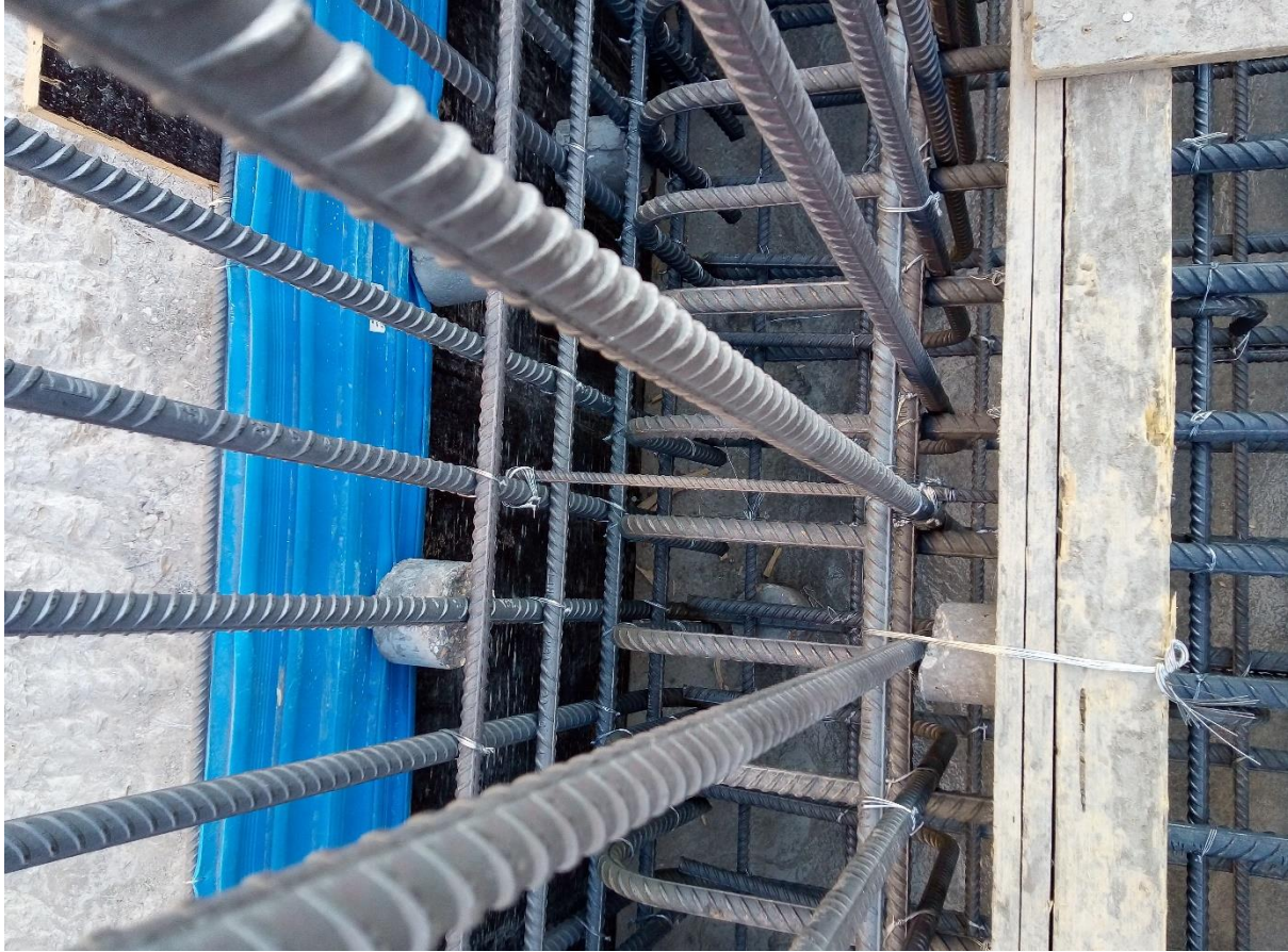
(شكل رقم 20) يوضح مقدار الغطاء الخرساني الداخلى والخارجى لجدار بواسطة (البسكوت)
