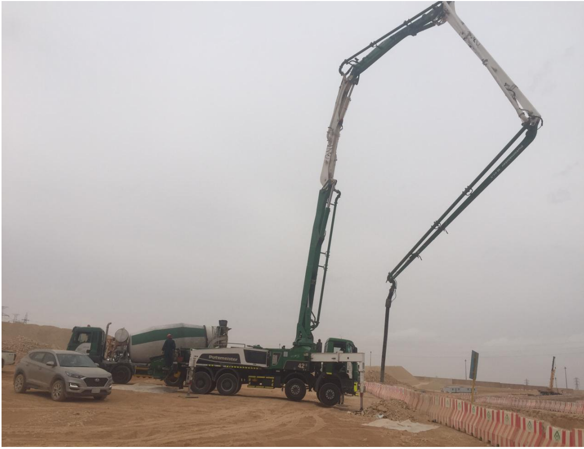
(شكل رقم 23) يبين المضخة (Pump) و الخلاط (Mixer) في الموقع
