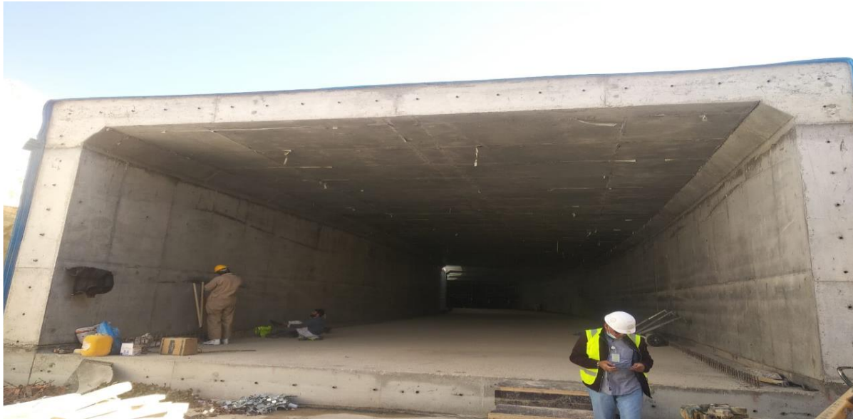
(شكل رقم 44) وقد تم اكتمال الوحدة وصب القاعدة والجدارين والسقف وفك الشدات الخشبية
