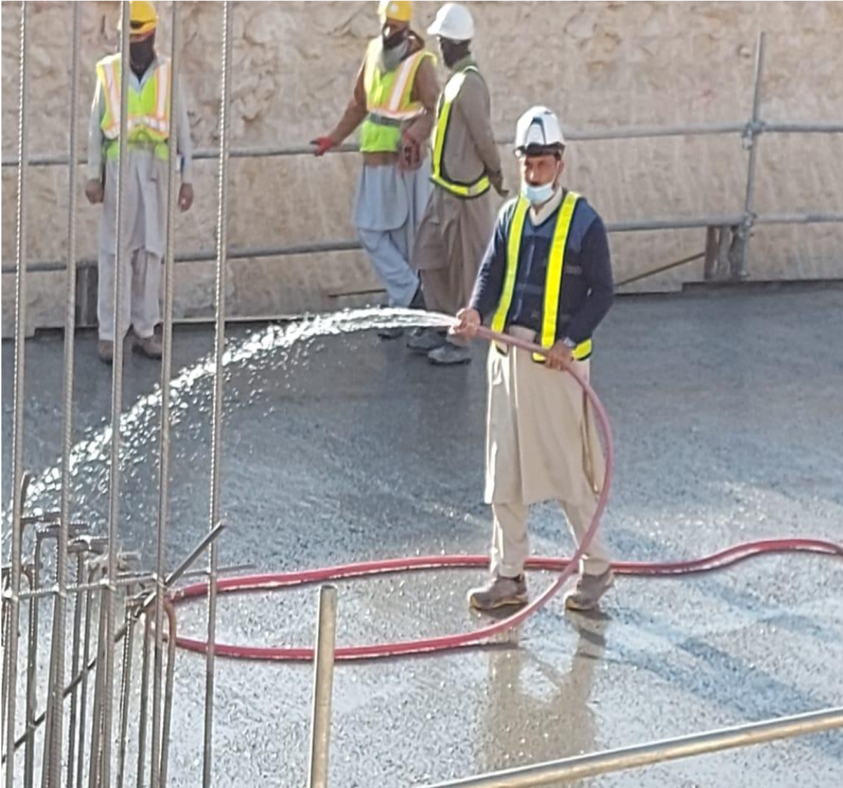
(شكل رقم 28) يلاحظ غمر الخرسانة بالماء بعد الصب
