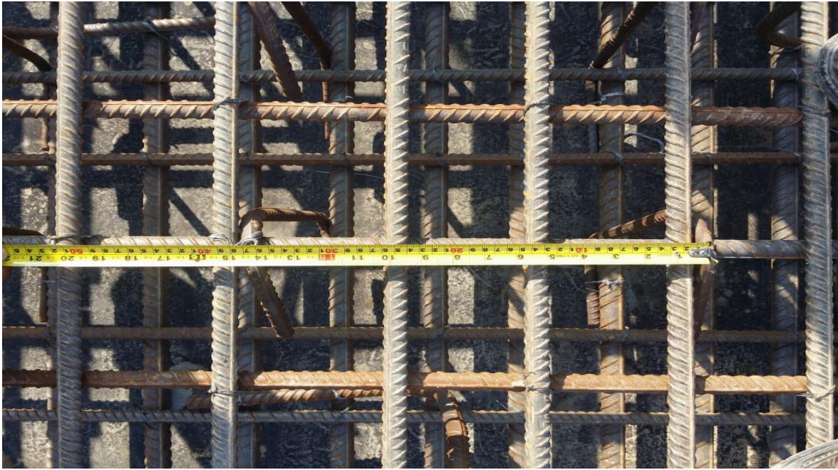
(شكل 19) يبين قياس المسافات بين اسياخ الحديد (Spaces)
