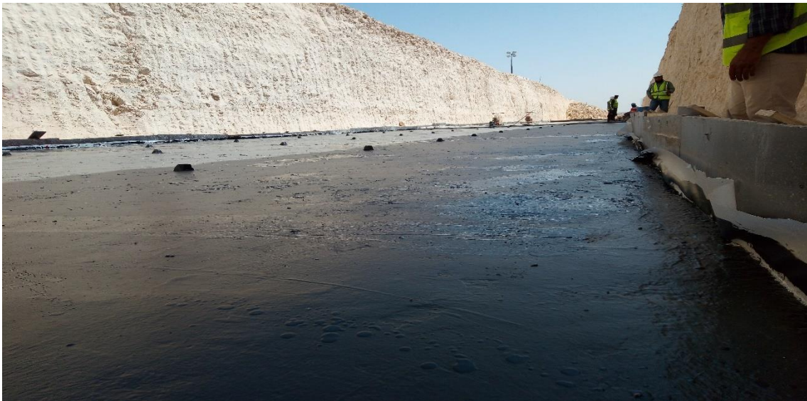
(شكل 11) يبين طبقتي البيتومين بعد صبة النظافة ويلاحظ عمل مستويات على ارتفاع 5 سم (بقج) استعدادا لصبة السكريد
