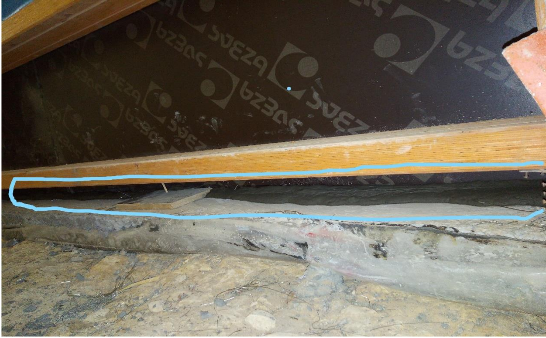
(شكل رقم 15) يلاحظ خشب جديد ولكن تسرب مونة الخرسانة من اسفل الفورم بسبب عدم التفتيل المحكم
