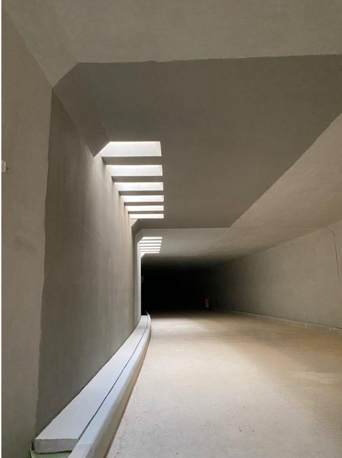
(شكل رقم 45) شكل النفق من الداخل وقد تمت عمليات الاصلاح (Repair)
