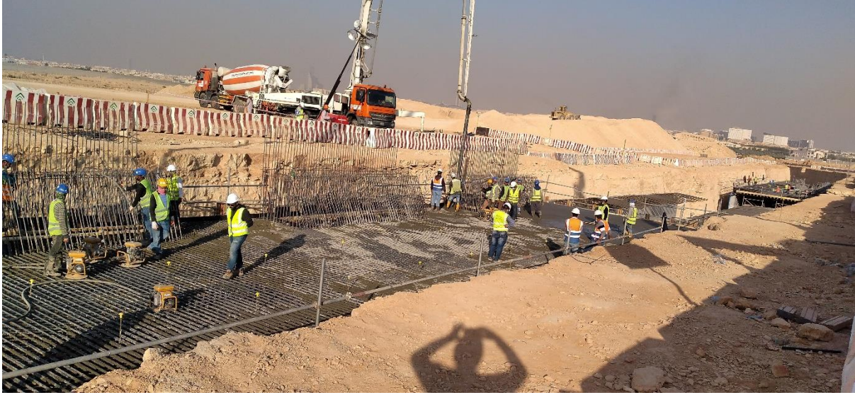
(شكل رقم 42) عملية صب السقف
