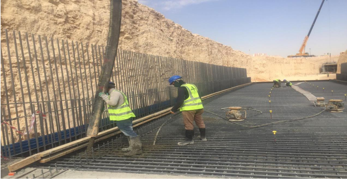
(شكل رقم 17) يلاحظ استعمال الهزازات اثناء الصب
