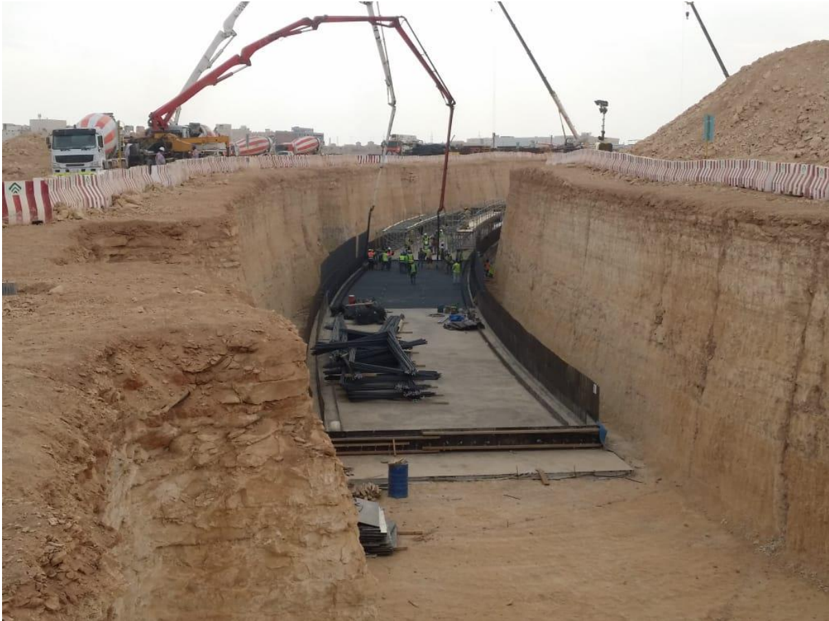
(شكل رقم 41) عملية صب خرسانة إحدى القواعد ويلاحظ اصطفاة الخلاطات وإفراغ الخرسانة داخل المضخة
