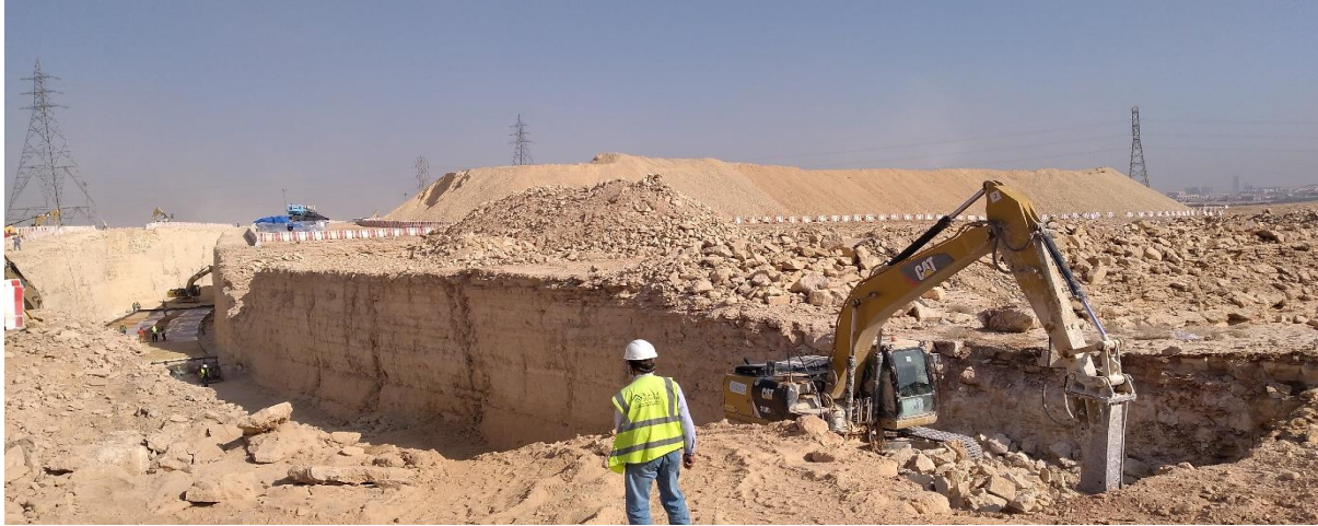
(شكل رقم 37) يوضح اعمال الحفر لإحدى الوحدات
