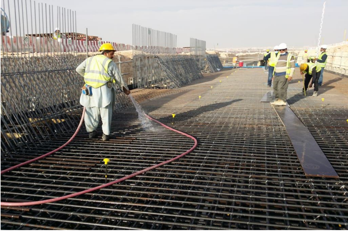
(شكل رقم 13) يبين رش الفورم بالماء قبل الصب
