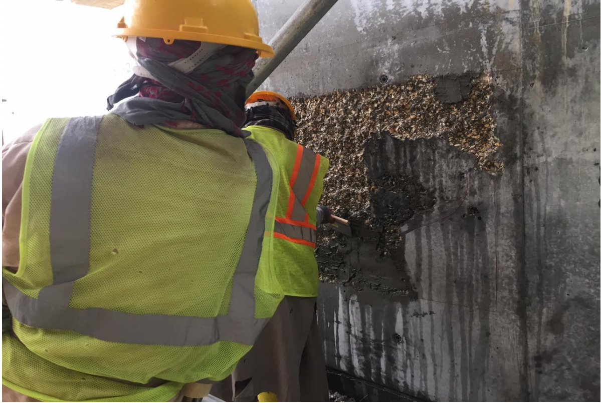
(شكل رقم 32) توسيع مكان التسوس وتعميقها حتى الوصول للجزء السليم
