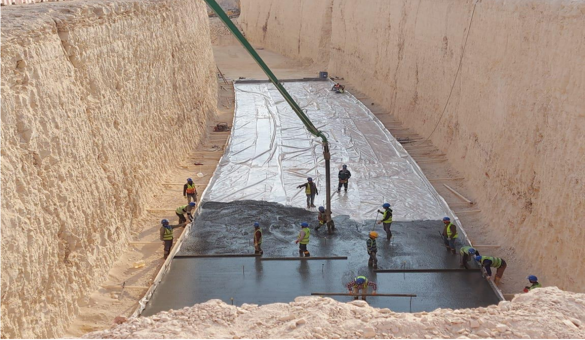
شكل رقم 10 يوضح صب خرسانة النظافة بعد وضع عازل الماء
