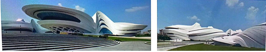
(شكل 13) يوضح مبنى Changsha meixihu international من الخارج وأسلوب استمرارية باستخدام خامة GRC
