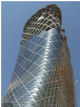
(شكل1) برج بوابة العاصمة دبي Capital Gate ويتضح منه استخدام خامة الفولاذ لتشكيل المبنى وتظهر بداخله كعنصر تصميمي
