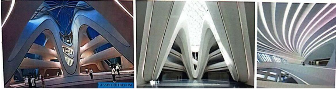
(شكل 14) يوضح استخدام خامة GRC بداخل المبنى و قوة الترابط في التصميم بين الخارج والداخل بنفس الأسلوب
