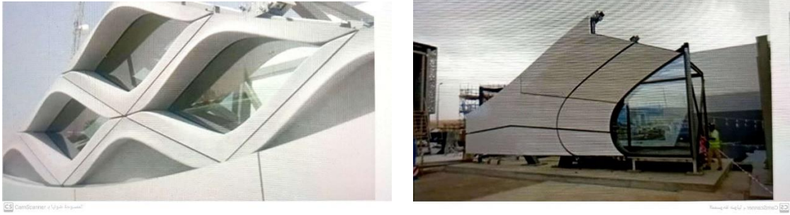
(شكل 9) يوضح تكسية الفولاذ بخامة PVC بعد قبولها بالخامة بالتشكيل المطلوب
