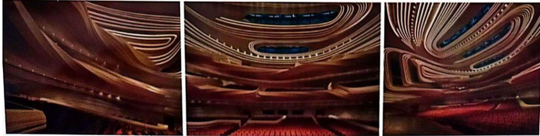
(شكل 15) يوضح انسجام تصميم المسرح الكبير للمركز مع الشكل الخارجي واستخدام خامة PVC وطريقة التواء الخامة والتنفيذ بإتقان دون فواصل أو انقطاع للتصميم
