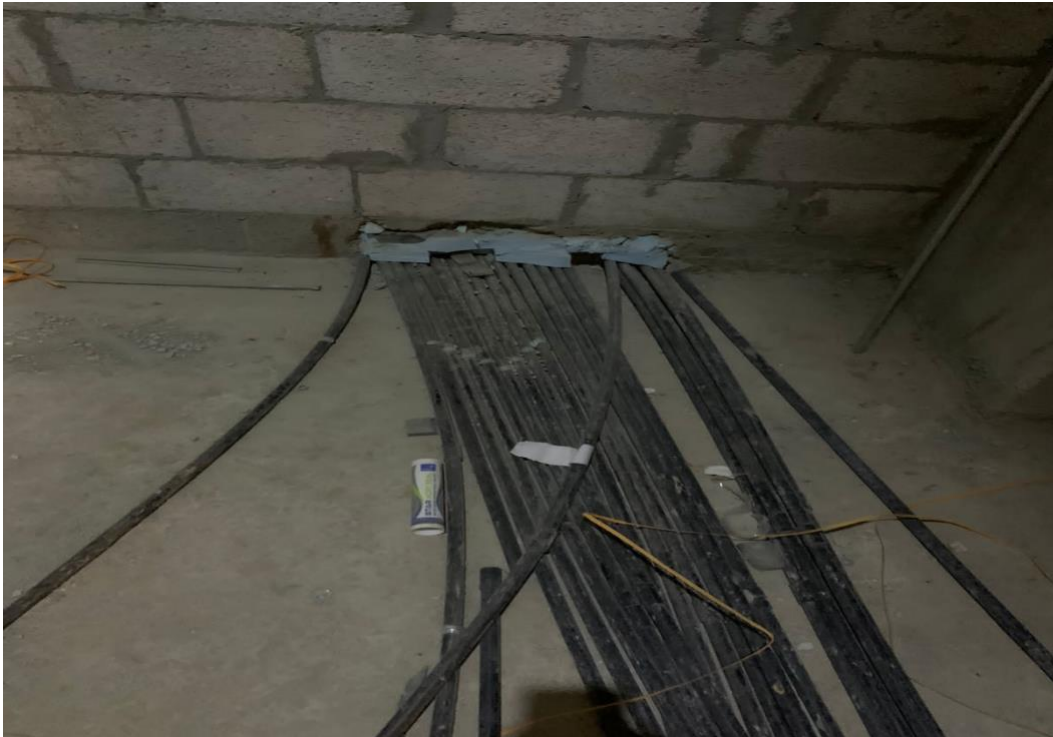
صورة رقم (16) عمليات وضع خراطيم الكهرباء في الفيلا السكنية
