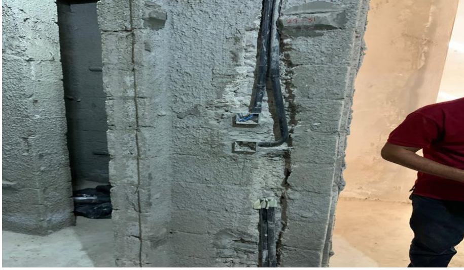
صورة رقم (14) عمليات بند الكهرباء في الفيلا السكنية
