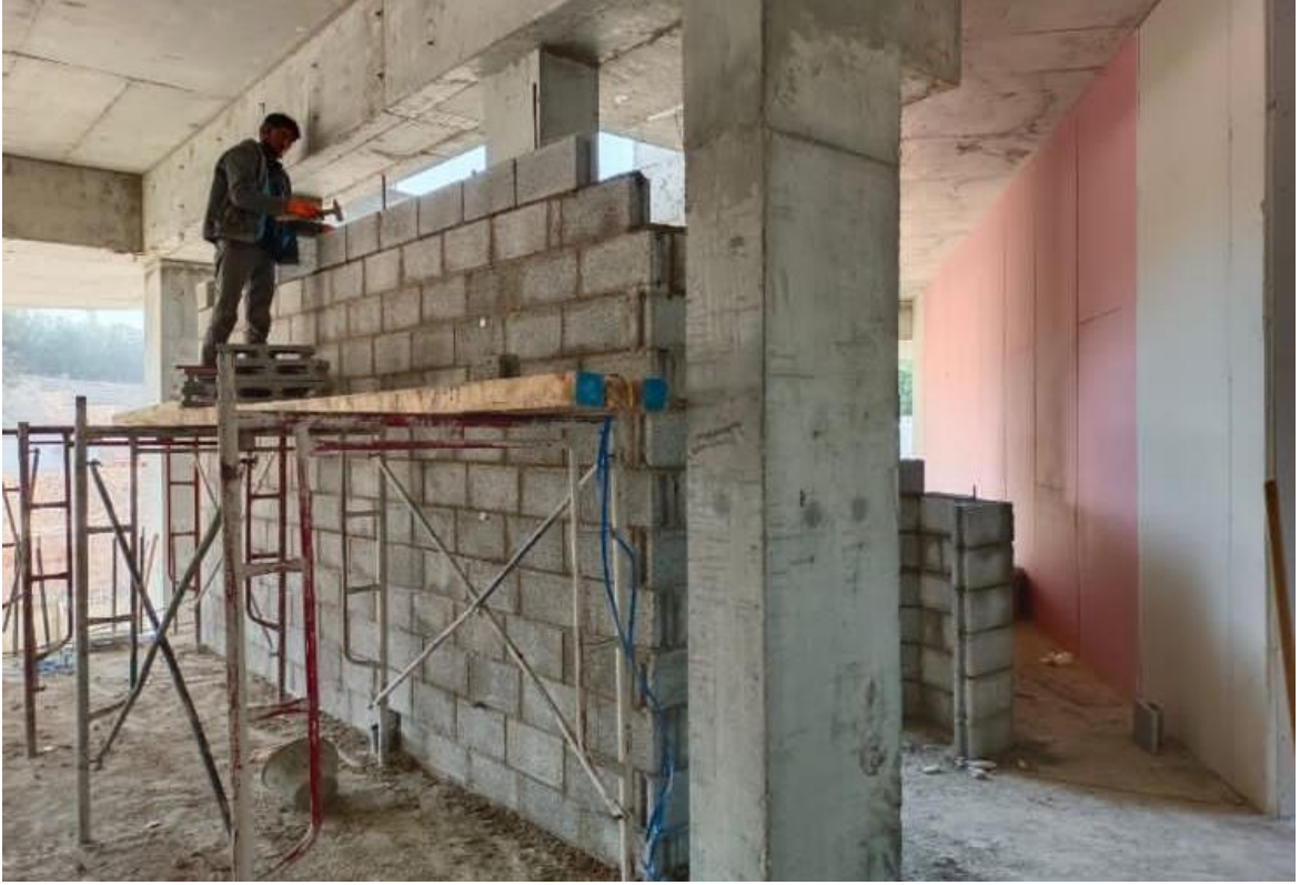
صورة رقم (11) توضح عمليات البناء في الفيلا السكنية
