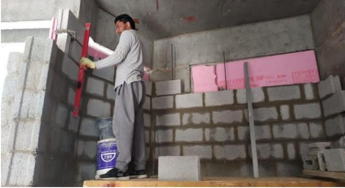
صورة رقم (13) توضح عمليات البناء في الفيلا السكنية
