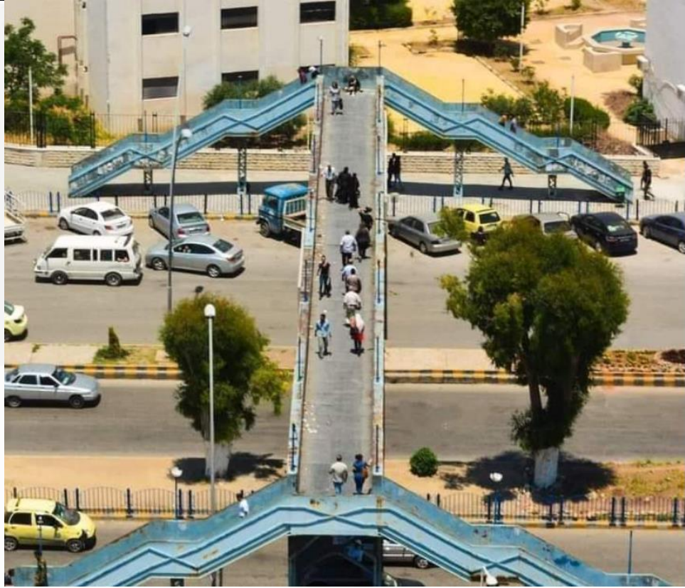
الشكل (10-2) - جسر المشاة - الجسر الازرق - بمدينة اللاذقية
