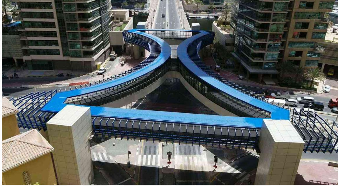
الشكل (2-5) - جسر للمشاة بمدينة دبي- منطقة المارينا : يلاحظ كثافة الأبنية المحيطة كما يلاحظ وجود جسر للمركبات والمشاة فوق القناة المائية
