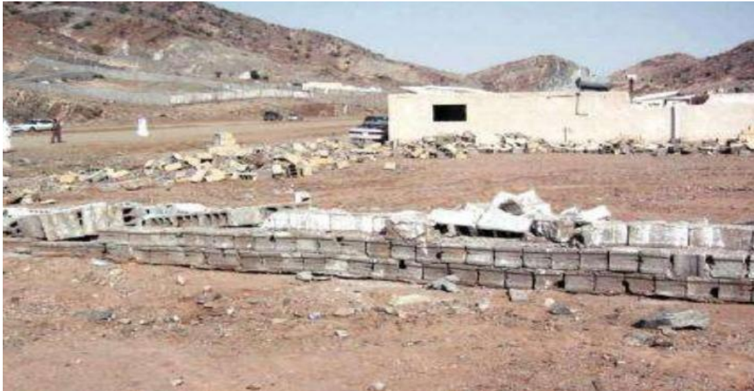
صورة رقم (٣٣) تجهيز الأرض للبناء. المصدر [مجلة واسط للعلوم الانسانية، العدد ١٠، ص ١٣٢].
